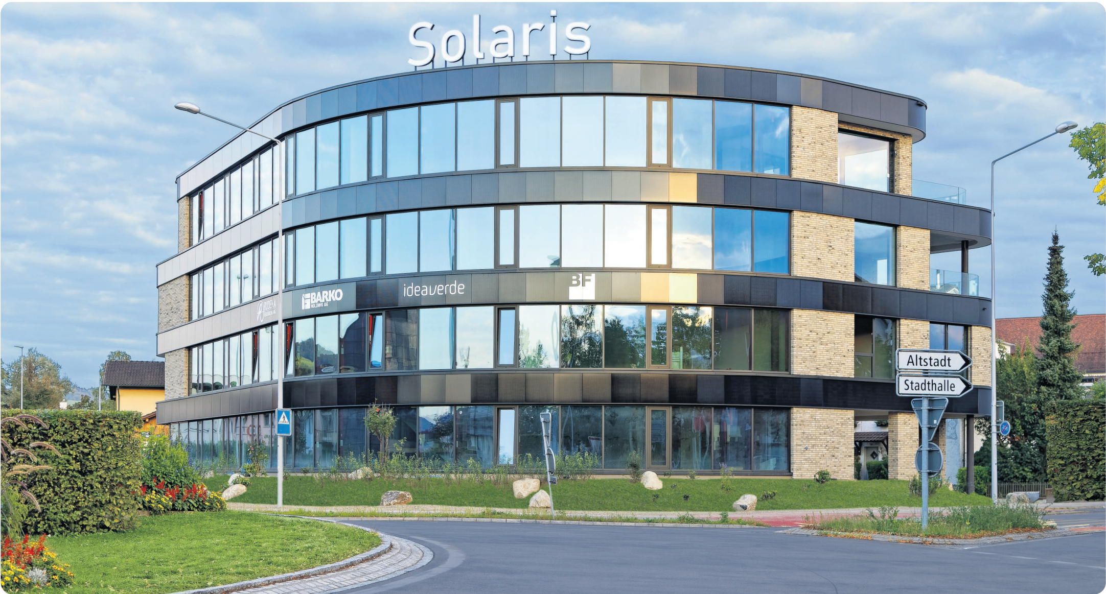
Das moderne Bürogebäude am Schlottermilchkreisel in Sursee setzt Massstäbe in Sachen Nachhaltigkeit. Foto sgrafik.ch
