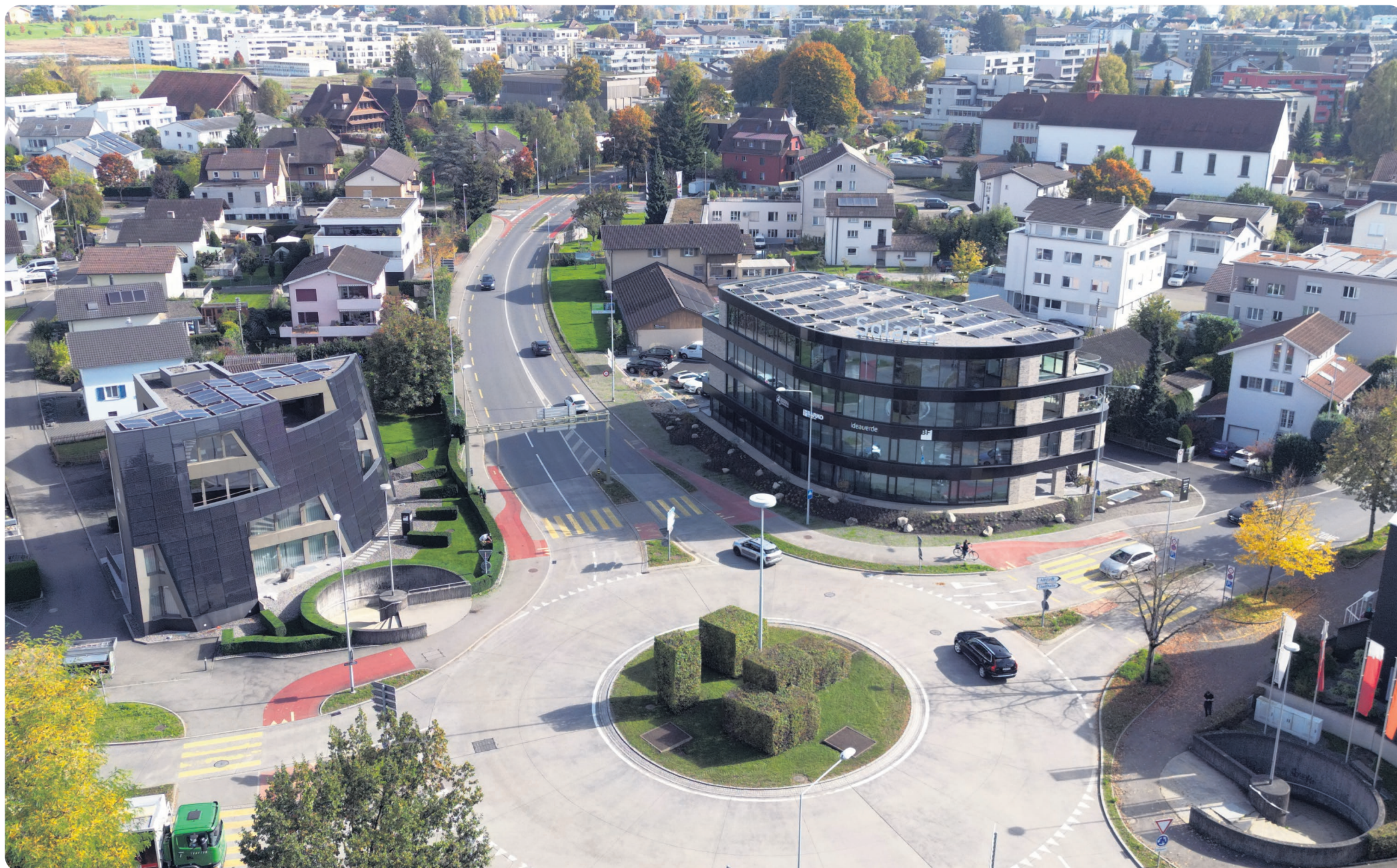
Drohnenaufnahme des neuen Solaris Gebäudes am Schlottermilchkreisel in Sursee. Foto BF architekten sursee ag
